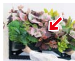
壁に取り付けた枠にグリーンを正面からはめ込みます。
