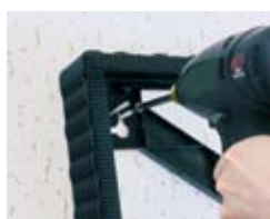
枠の吊下げ穴の位置で壁にビスを打ち枠を固定します。
